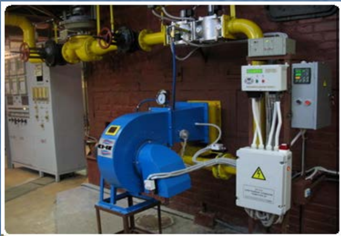
Пальниковий пристрій стабілізаторного типу до котла ПТВМ-50
