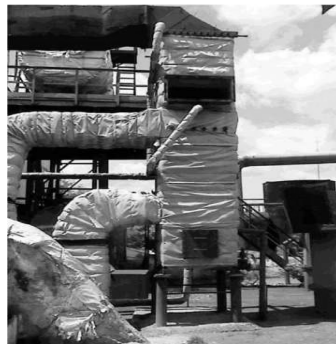
Контактна комбінована теплоутилізаційна установка
