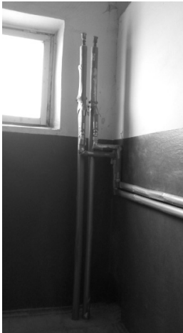
Рис. 5. Фрагмент прокладки нових стояків в під'їзді.
