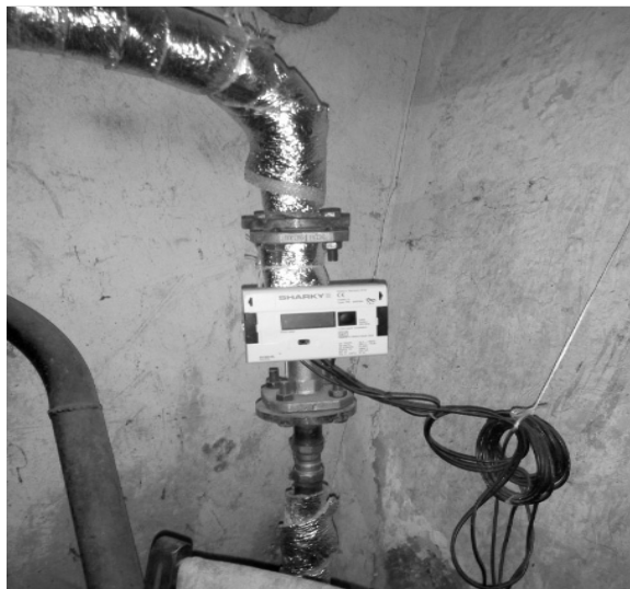
Рис. 4. Існуючий загальнобудинковий прилад обліку споживання теплової енергії.
