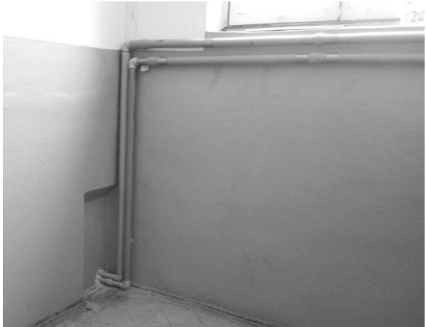
Рис. 6. Фрагмент нових введів в квартиру з під'їзду.
