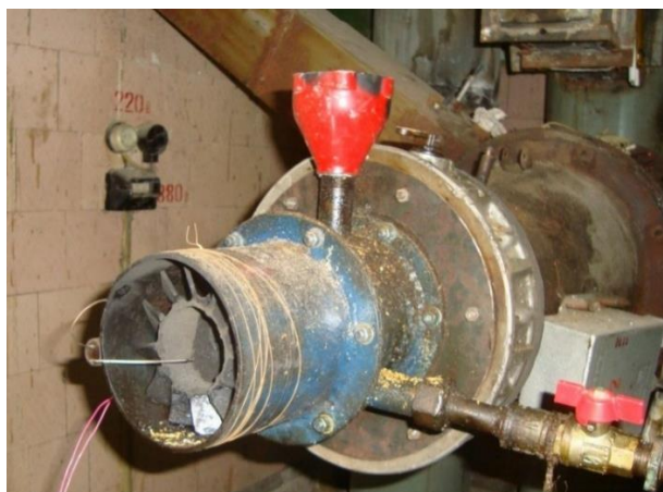
Рис. 2.18. Пальниковий пристрій двостадійного горіння палива
