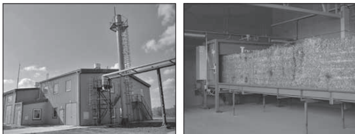
Рис. 11.24. Парова котельня компанії «Нива Переяславщини»
