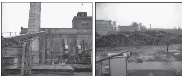
Рис. 11.3. ТЕЦ «Сміланергопромтранс», м. Сміла Черкаської обл. (котельне обладнання переведено на спалювання біомаси)
