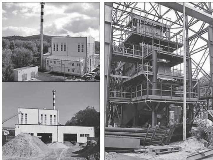
Рис. 11.19. Котел Vynske (18 т пари на годину, тиск пари 20 бар, температура 250 °С)
