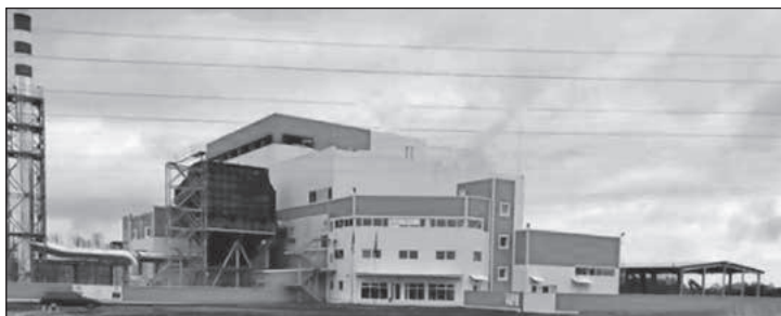
Рис. 11.4. ТОВ «Біогазенерго», ТЕС, смт Іванків Київської обл. (нове будівництво)
