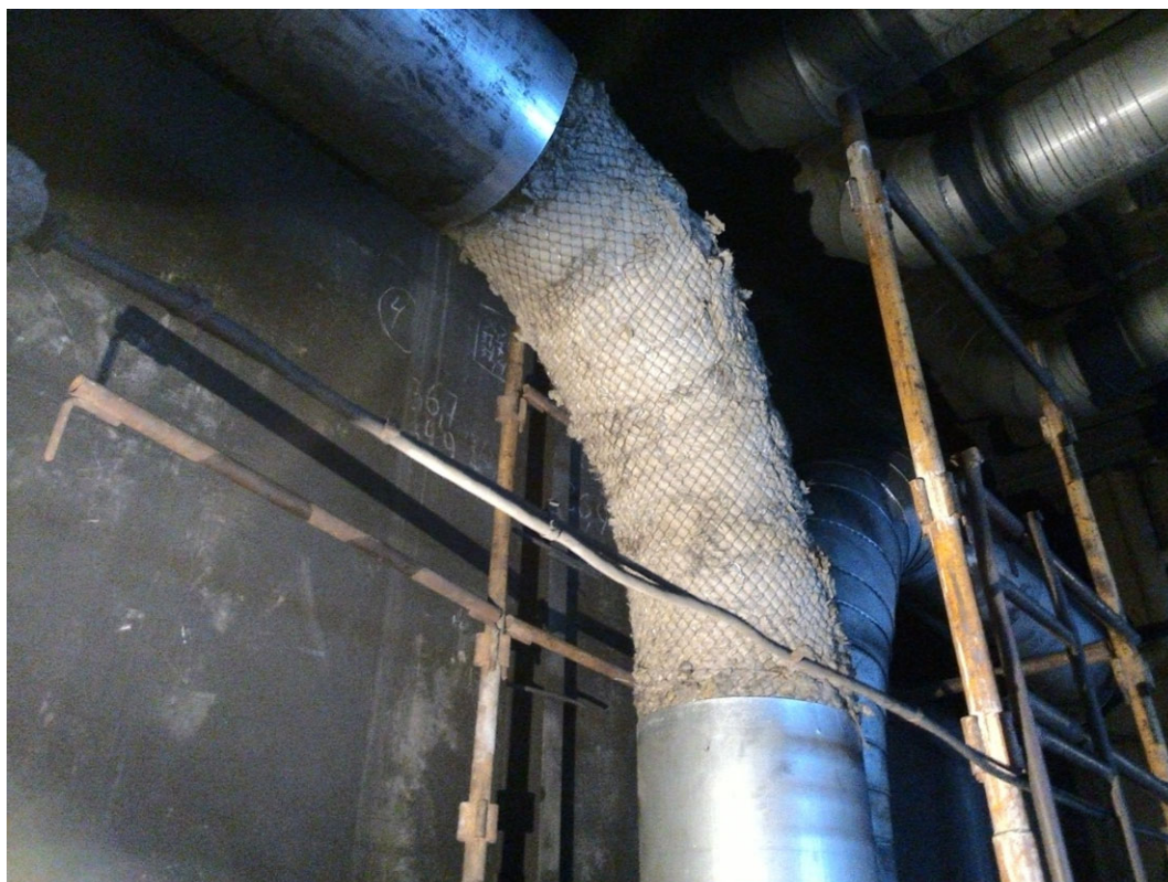
Рисунок 6. 10 - Зразок 1 (МТПБа 30), паропровід СП, відм. +29,0 м.
