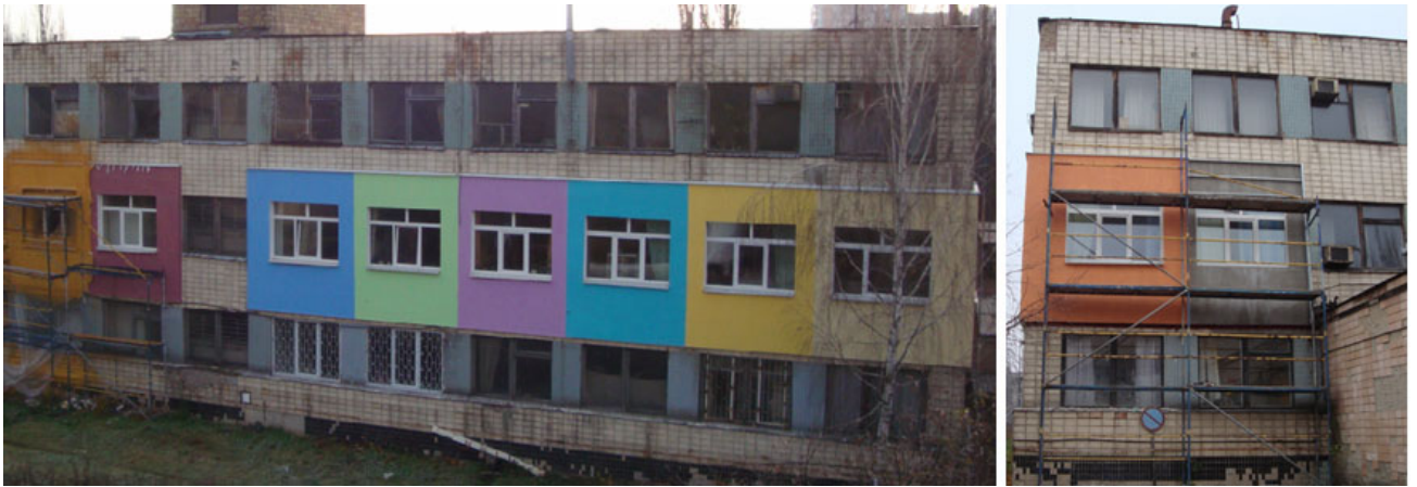
Рисунок 6. 21 - Частина експериментальної ділянки стіни з різноваріантної термомодернізації будівлі
