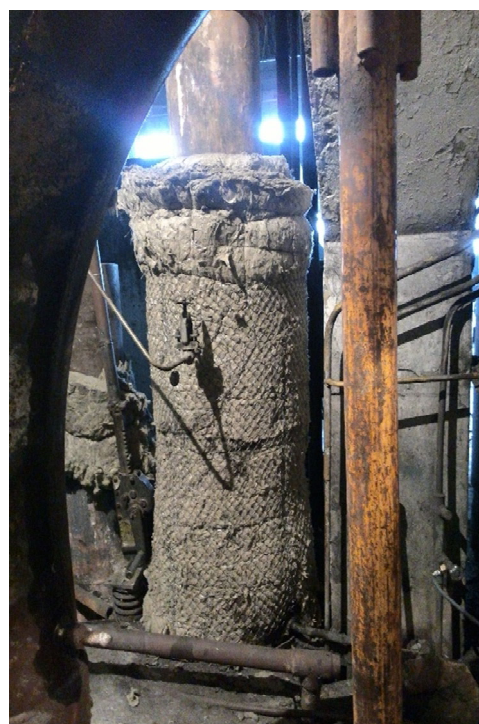
Рисунок 6. 10 - Зразок 1 (МТПБа 30), паропровід СП, відм. +29,0 м.
