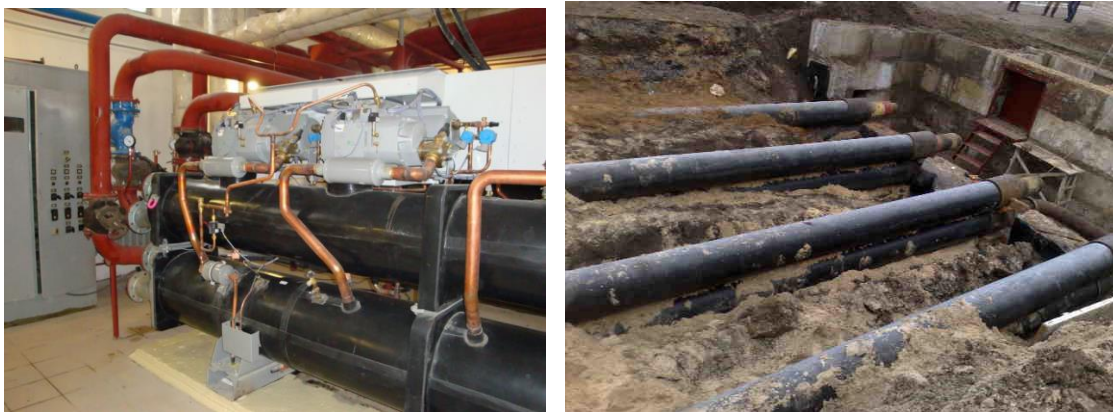
Рис.6.22. Загальний вигляд теплового насоса 30NXC 200-PH3 Carrier і підземного теплообмінника-утилізатора на стадії монтажу
