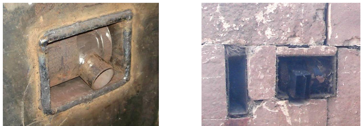
Рис. 4.13. Початкова конструкція круглого сопла вторинного дуття (зліва) та реконструйоване сопло вторинного дуття зі зниженою швидкістю повітря (справа).
