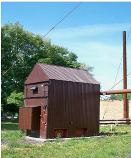
Рис. 4.8. Соломоспалювальний котел потужністю 350 кВт встановлений в с. Стави, Київська обл.
