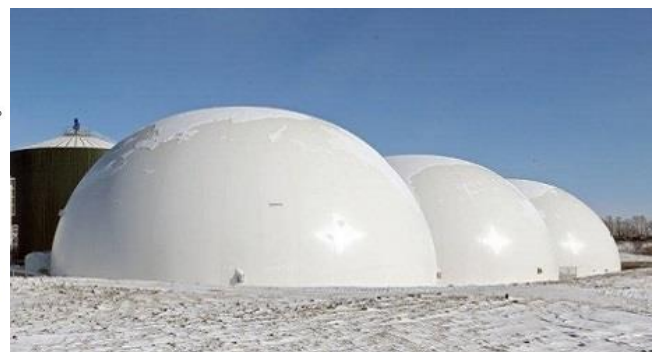
Рис. 3.20. Газгольдери гнучкі острівного типу
