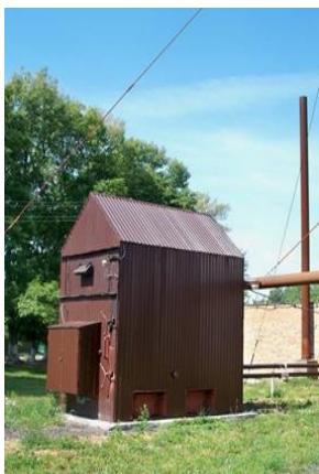
Рис. 10. Соломоспалювальний котел конструкції ІТТФ НАНУ потужністю 350 кВт встановлений в с. Стави, Київська обл.
