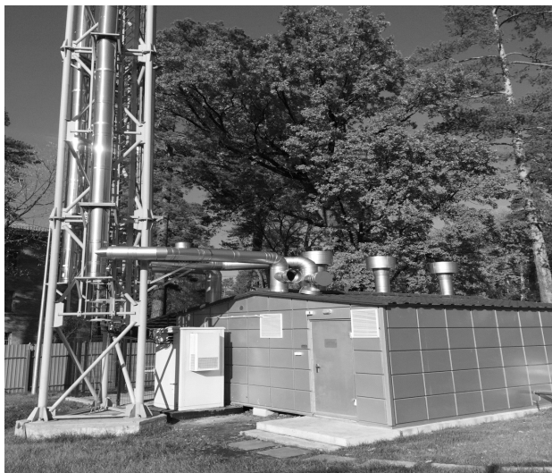
Зовнішній вигляд транспортабельної котельні серії «TransExpress».
