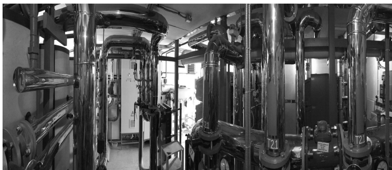
Внутрішній вигляд котельні серії «TransExpress».
