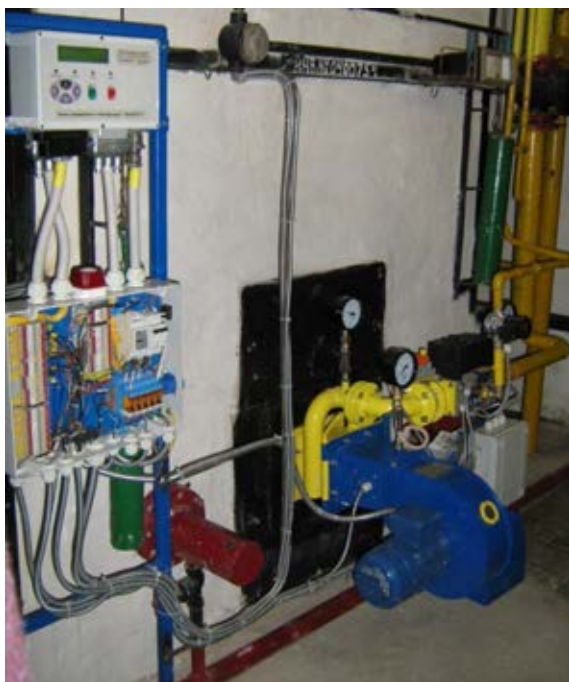
Рис. 7.5 Котел НИИ СТУ-5 з ПП СНТ
