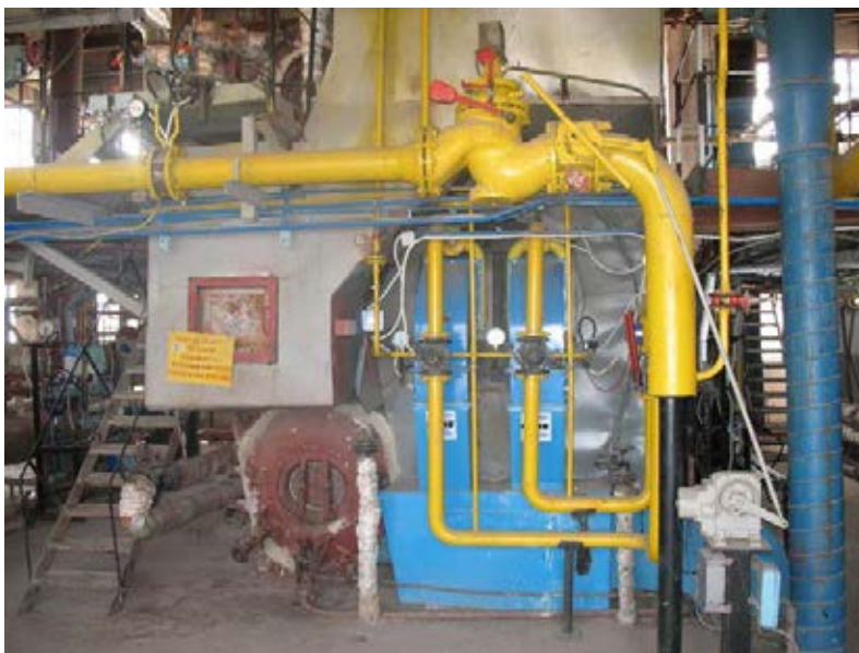
Рис.7.36 Котел ДЕ-25, м. Южний.
