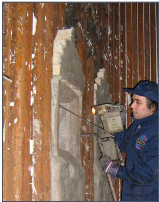
Рис.7.40 Профіль амбразури пального пристрою типу СНТ
