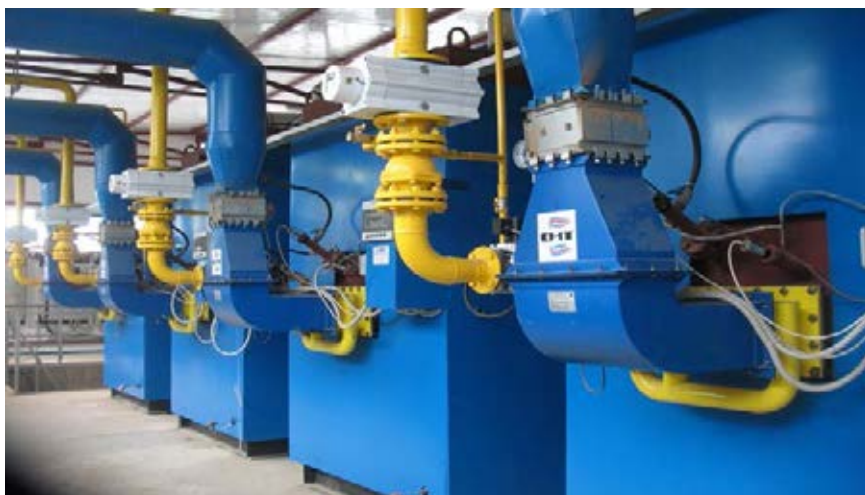
Рис. 7.3 Контактний водопідігрівач з ПП СНТ
