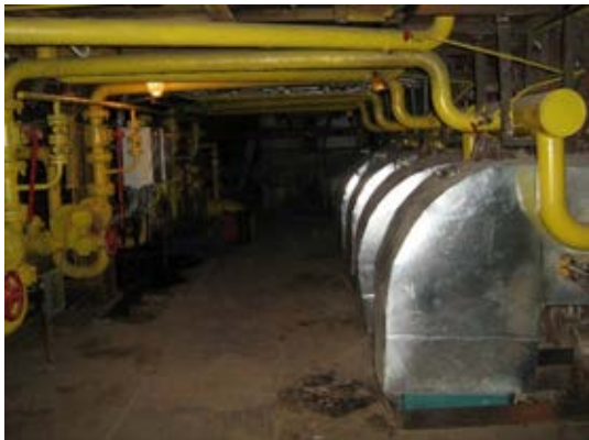
Рис. 7.37 Котел БК3-160 Одеська ТЕЦ
