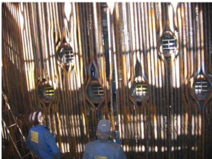
Рис. 7.28 Установка ПП СНТ в існуючу амбразуру для штатних паливників. Котел ПТВМ-50
