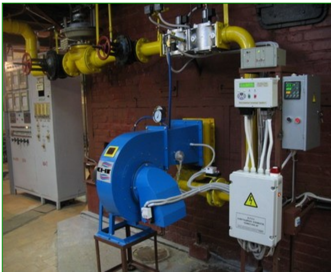
Рис. 25. Блочний палинковий пристрій на основі струменево-нішових систем потужністю 8 МВт у складі котла ДКВР-10/13.
