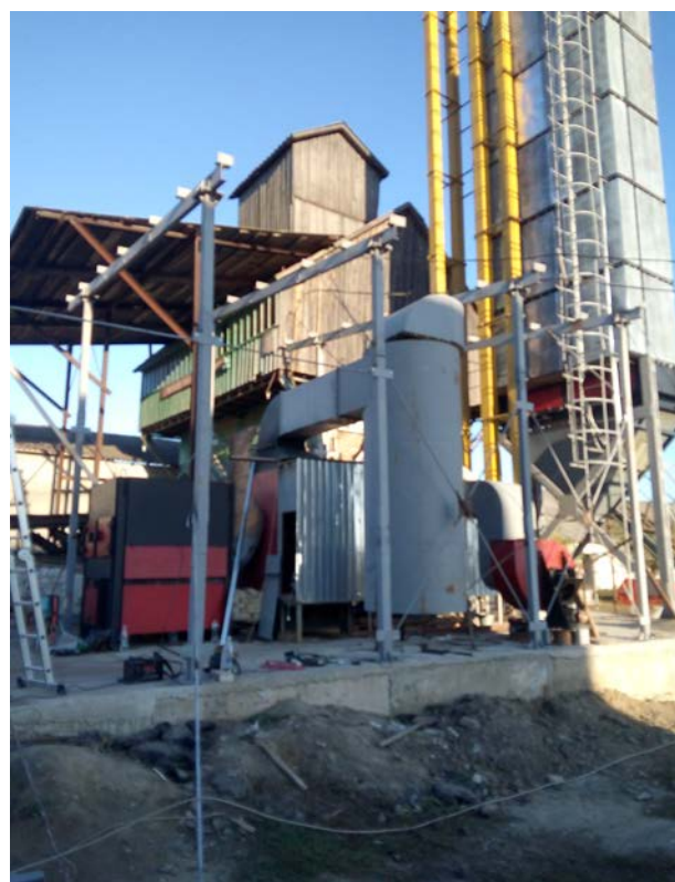
Рис. 6.17. Монтаж шахтної зерносушарки продуктивністю 5 т/год 6. Монтаж секцій зерносушарки. 7. Встановлення завантажувального бункера.
