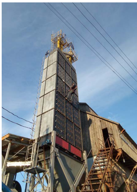
Рис. 6.17. Монтаж шахтної зерносушарки продуктивністю 5 т/год 6. Монтаж секцій зерносушарки. 7. Встановлення завантажувального бункера.
