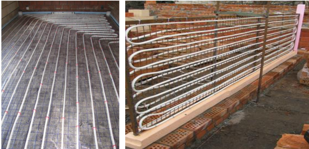
Рис. 7.24. Опалювальні прилади дослідного приміщення енергоефективного будинку
