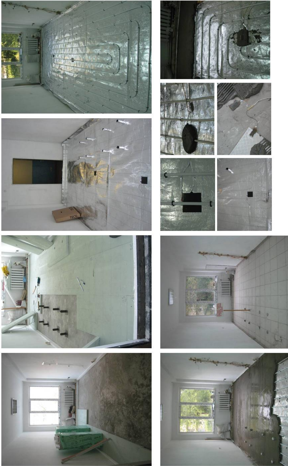
Рис. 6.5. Поступне створення системи водяного підлогового опалення
