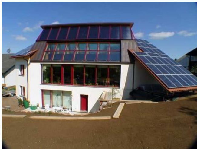
Рис. 7.5. Зовнішній вигляд першого енергоефективного будинку
