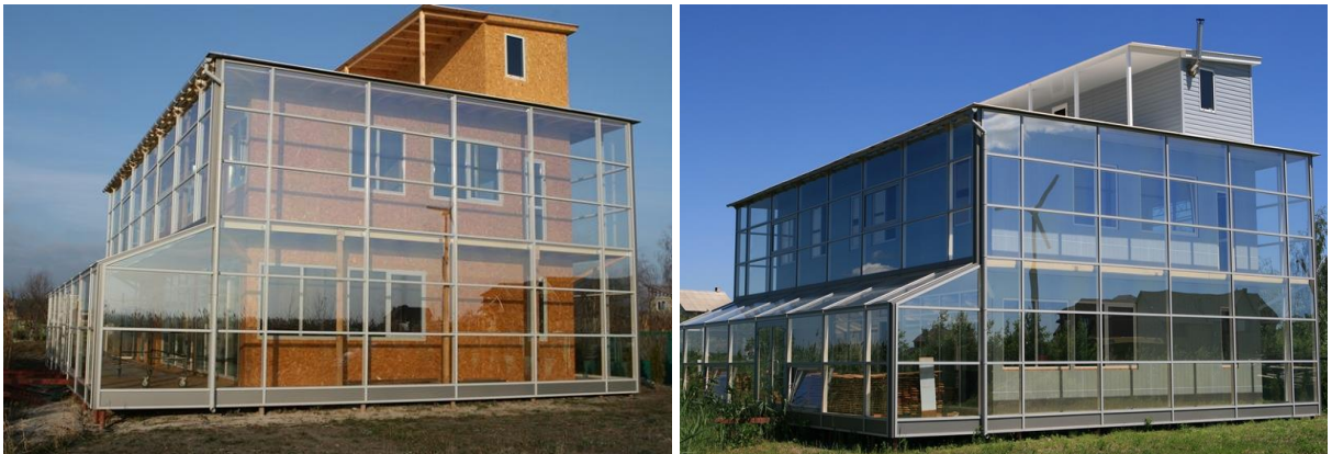
Рис. 7.10. Приватний енергоефективний будинок «пасивного» типу в Київській обл.
