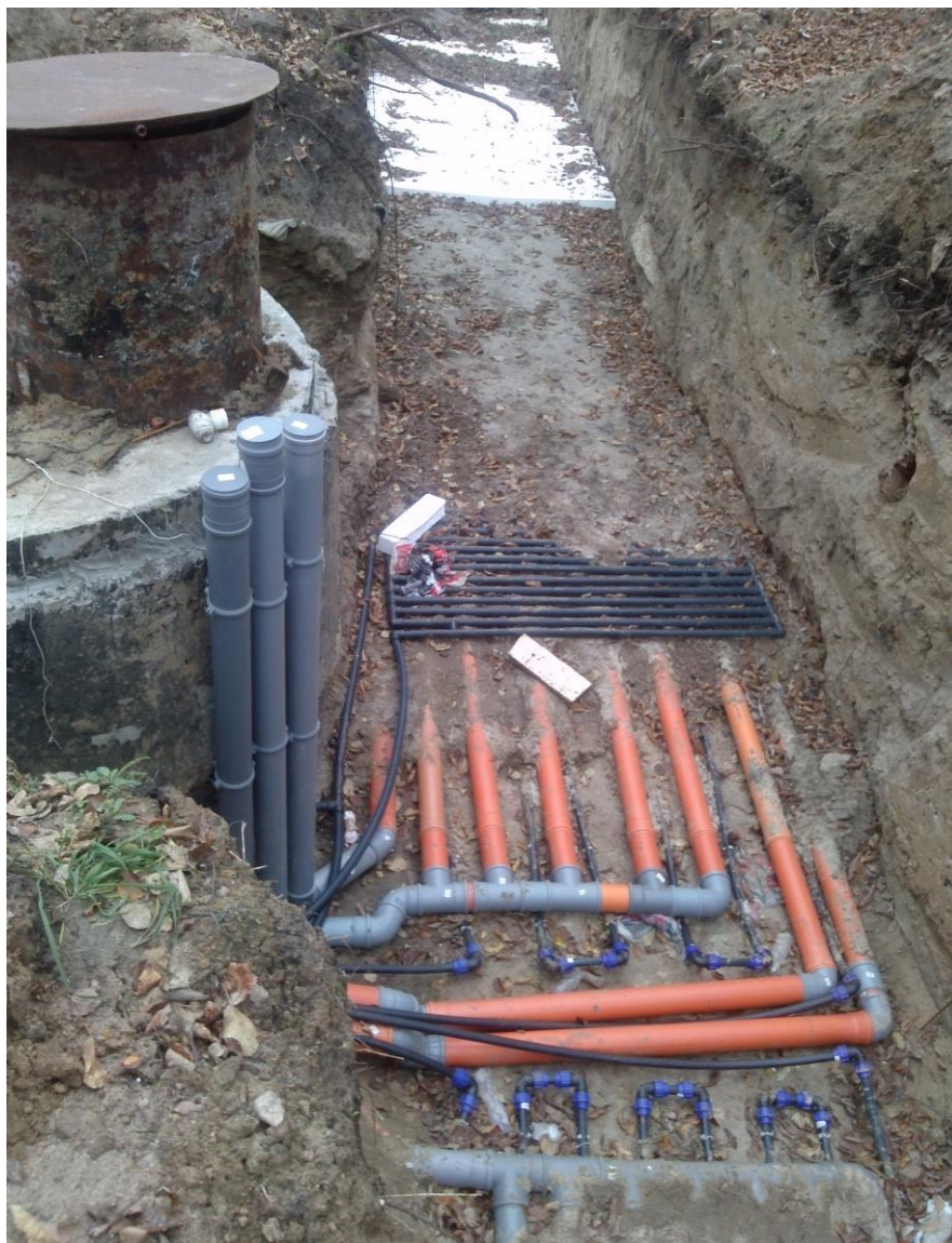
Рис. 7.14. Теплообмінники типу «грунт – повітря»
