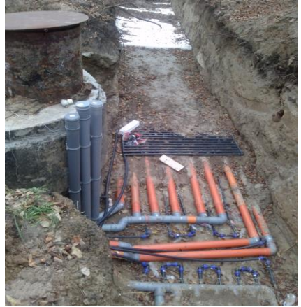
Рис. 21. Теплообмінники типу «ґрунт – повітря» системи повітряної завіси фасадів енергоефективного будинку
