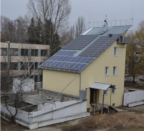
Рис. 20. Загальний вигляд енергоефективного будинку після теплоізоляції ОК
