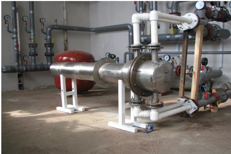
Рис.4.10. Кожухотрубний теплообмінник «ТКГ-350» в тепловому пункті під час випробувань
