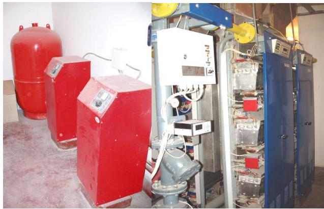
Рис.4.14. Зовнішній вигляд СКТ з газовими та електрокотлами
